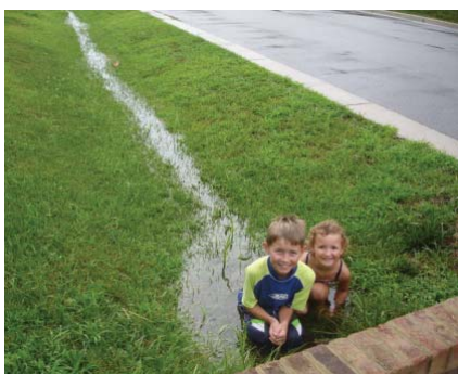
Eksempel på en grøn vejrabat, der er udformet med grøft til opsamling af regnvand.
