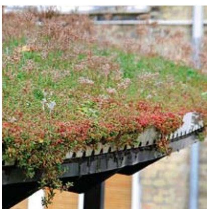
Grønne tage har betydning for klimaet og kan fx. reducere en bygnings energiforbrug til køling. Grønne tage kan forlænge tagenes levetid.
